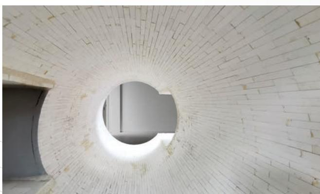
**Плитка из оксида алюминия содержит  $Al_2O_3$  92–95% и обладает следующими свойствами:**
